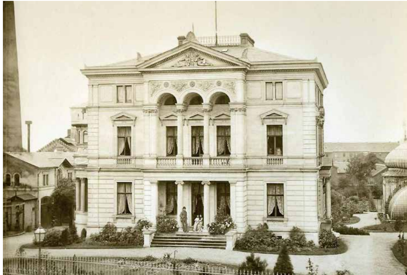
Könnte diese Villa an der Ruhrstraße 78 reden, so hätte sie viel über die vergangenen 147 Jahre der Geschichte Wittens zu erzählen. Gebaut wurde das zweigeschossige Gebäude 1873 von der Unternehmerfamilie Brand-Lohmann. Wie Stadtarchivarin Dr. Martina Kliner-Fruck berichtet, entstand das historische Foto um das Jahr 1880. Die Villa wurde 1903 von Wilhelm und Adele Dittmann erworben und steht seit 1985 unter Denkmalschutz. Auch 75 Jahre nach Ende des
