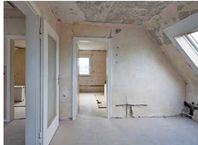
Damit das Dachgeschoss nach dem Dachausbau viel Wohnkomfort bietet, sollten Hausbesitzer vor der Sanierung ihre Vorstellungen zusammenfassen und mit einem Planer besprechen. Zu diesem Zeitpunkt werden dann auch die gesetzlichen Vorgaben und eine mögliche KfW-Förderung geprüft. Foto: KfW-Bildarchiv; Fotograf: Frank Homann www.pressefoto-homann.de
