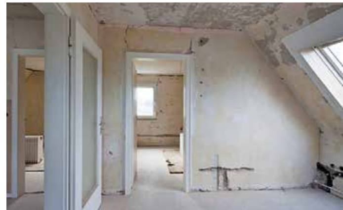
Damit das Dachgeschoss nach dem Dachausbau viel Wohnkomfort bietet, sollten Hausbesitzer vor der Sanierung ihre Vorstellungen zusammenfassen und mit einem Planer besprechen. Zu diesem Zeitpunkt werden dann auch die gesetzlichen Vorgaben und eine mögliche KfW-Förderung geprüft. Foto: KfW-Bildarchiv, Fotograf: Frank Homann www.pressefoto-homann.de
