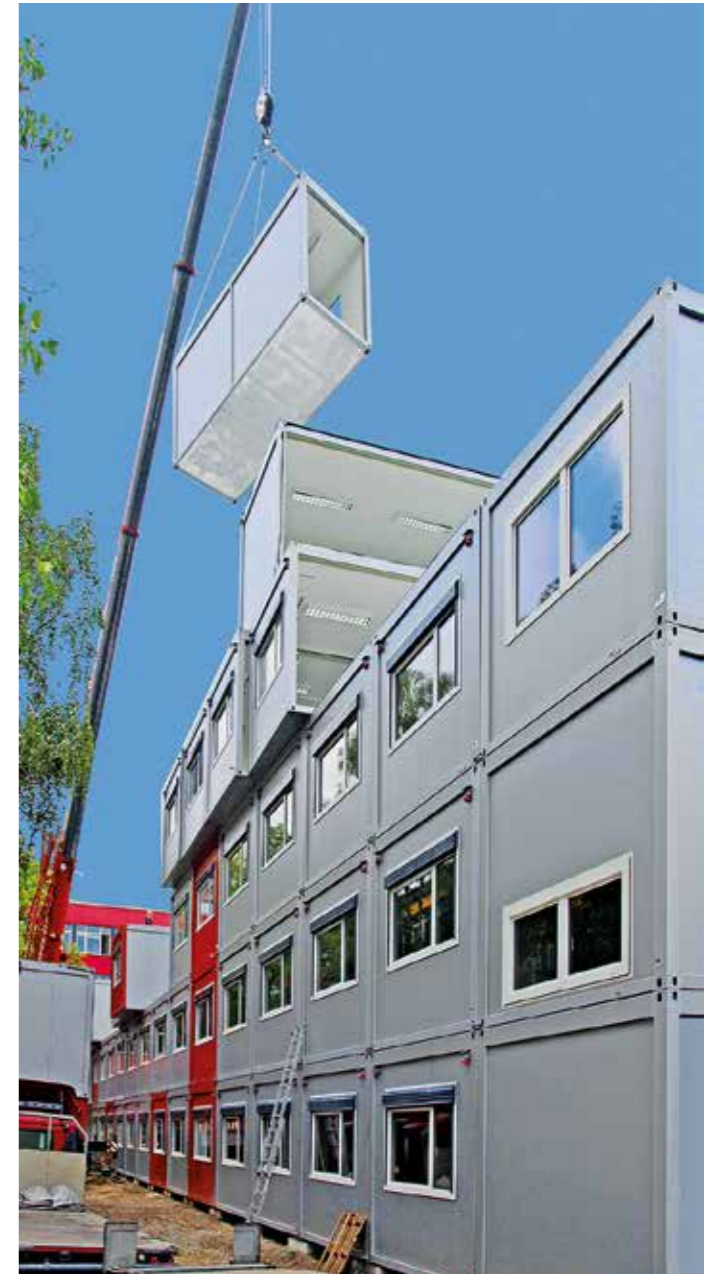
„Die Container werden von wechselnden Schülern genutzt, bis alle vier Bauabschnitte abgeschlossen sind“, sagt Martin Proske. Dies wird bis Ende 2024 dauern. Foto: Rainer Schletter
