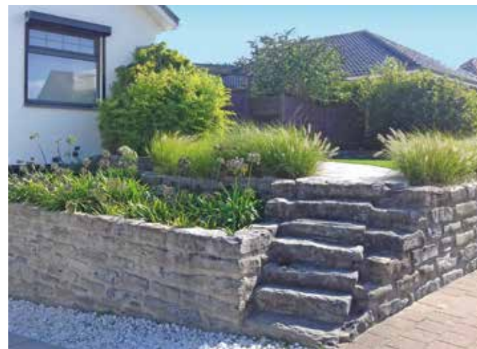
Foto: BGL. - Steine im Vorgarten können von ganz praktischem Nutzen sein. Liegt das Grundstück am Hang, kann zum Beispiel mit einer Natursteinmauer und integrierter Treppe eine gerade Fläche modelliert werden.
