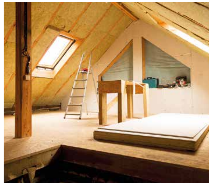
Mineralwolle ist für den Dachausbau optimal geeignet. Der Hochleistungs-Dämmstoff spart nicht nur viel Heizenergie, sondern verbessert auch den Brand- und Schallschutz erheblich. Der Staat unterstützt diese Leistungsfähigkeit mit deutlichen finanziellen Zuschüssen im Rahmen einer energetischen Sanierung. txn-Foto: ArtusBudkevics@123rf/Ursa
