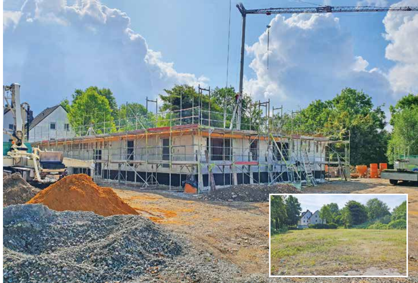
Bauplatz und Rohbau
