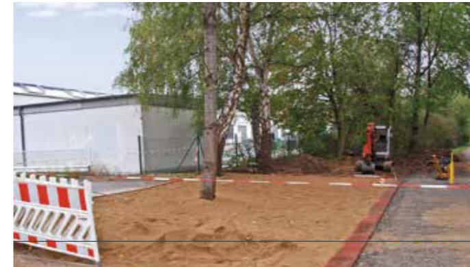
Bei den Arbeiten handelt es sich um Vorbereitungen für die Herstellung einer weiteren Boulebahn und eine Pflasterfläche für eine Pausenstation
